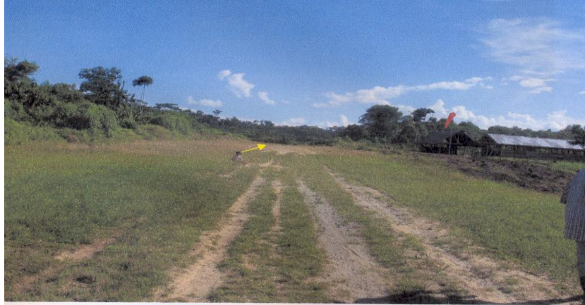
AL FONDO, CABECERA DE LA PISTA 04 LA FLECHA INDICA EL PUNTO DE CAMBIO DE PENDIENTE
