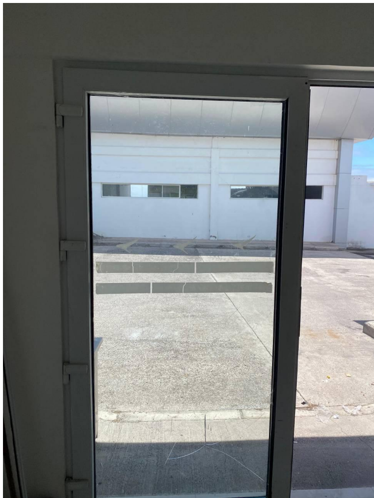
Bodega AERO EXPRESO 1 (Puerta de Aluminio y vidrio vista de la parte interior)
