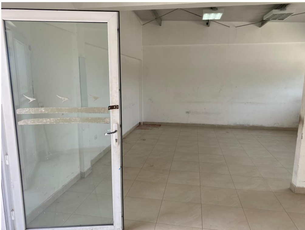
Bodega AERO EXPRESO 1 (Puerta de Aluminio y vidrio, paredes empastadas y pintadas, piso de con recubrimiento de cerámica, luminarias fluorescentes)
