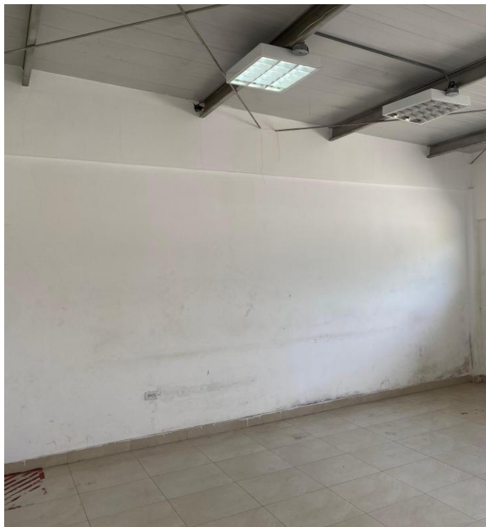
Bodega AERO EXPRESO 1 (Luminarias, estructura metálica de cubierta, paredes empastadas y pintadas)
