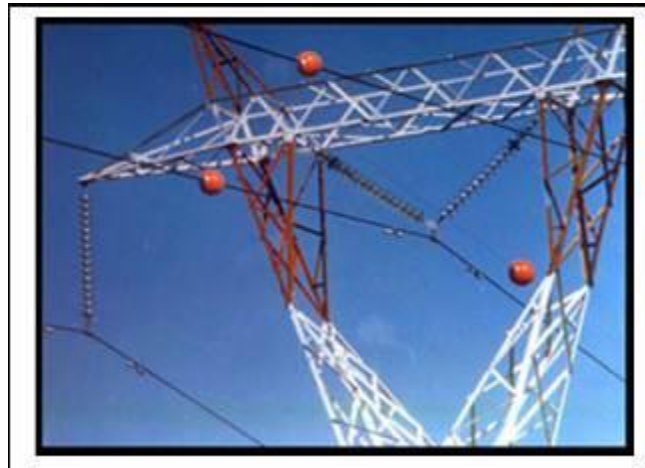
Figura 4-2. Señalamiento de líneas de tensión con esferas de un solo color
