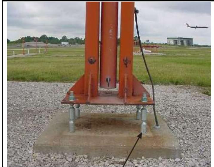
**FiguraADJB-3. Aplicación de un pernofusible**
