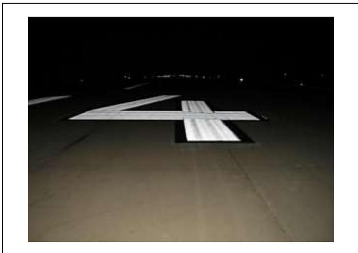
Figura C-8 Procedimiento aceptable de aplicación de la pintura con microesferas
