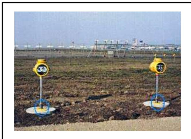
Figura ADJB-6. Ejemplos de Cuplas Frangibles montaje de tubos en Luces de aproximación
