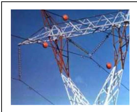
Figura 4-2. Señalamiento de líneas de tensión con esferas de un solo color
