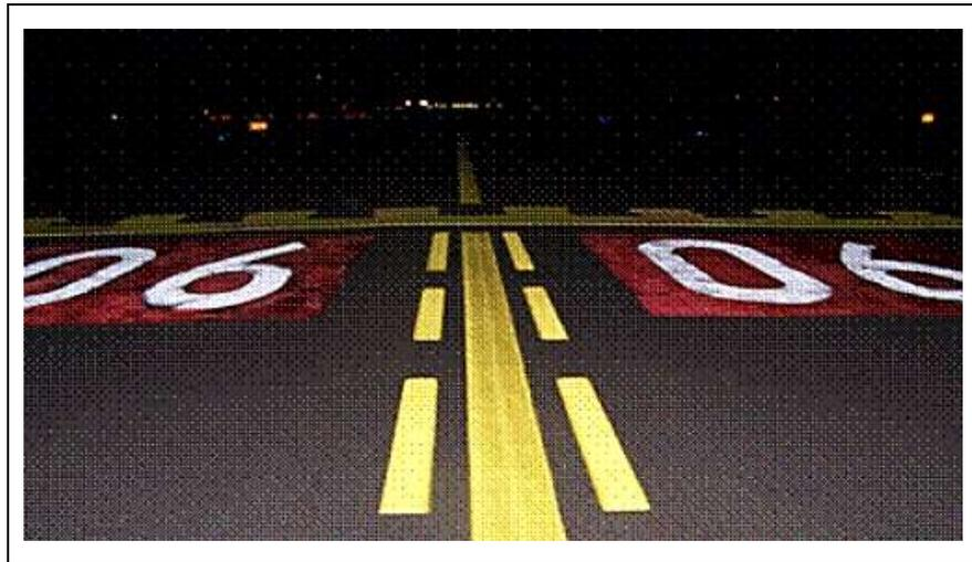
Figura C-1. Señalización retroreflectiva en Área de Movimiento - Punto de espera en calle de rodaje – Señal mejorada – Pintura con microesferas de vidrio.
