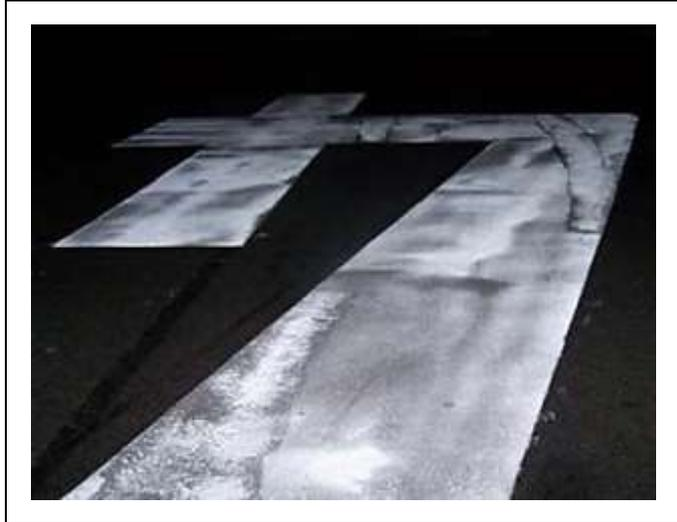
Figura C-9 Procedimiento no aceptable de aplicación de la pintura con microesferas
