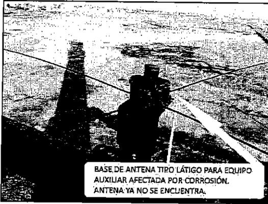
*Antena de equipo auxiliar pos. TWR FUSER.*
