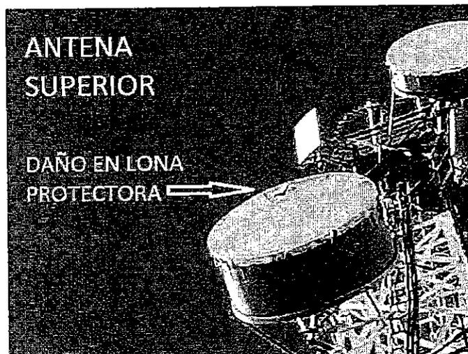
*Antenas de microondas del Radioenlace con visible daño en lonas de protección.*
