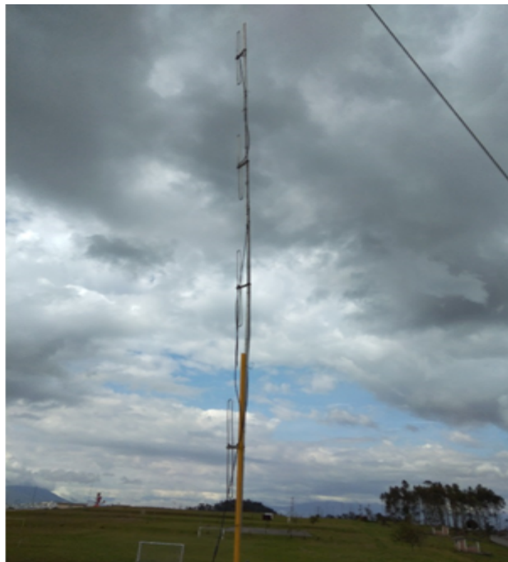
ANTENA DIRECTIVA DE 6dBi cobertura PALAD, MIDEX TMA-APP-UIO
