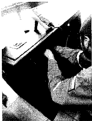
Remplazo de baterías UPS torre de control
