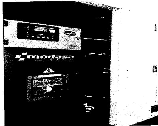
Fig. 2 Grupo electrógeno, terminal, P=581KVA.
