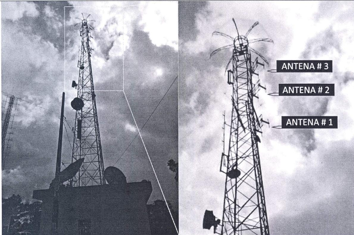
Luego de revisión física de todas las líneas de alimentación de las antenas, se determina que estas se encuentran en buena condición, por lo que el daño se ubica en las antenas.
