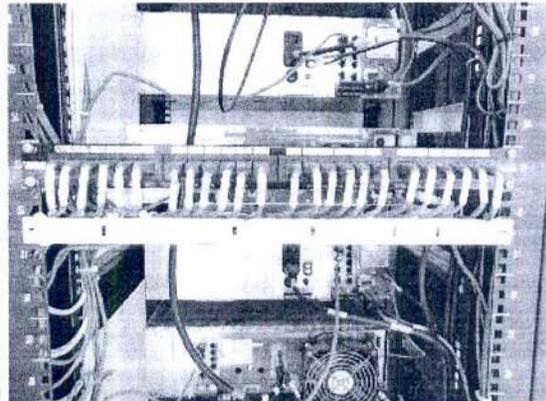
Nuevo Panel de Conexiones, con cableado ordenado
