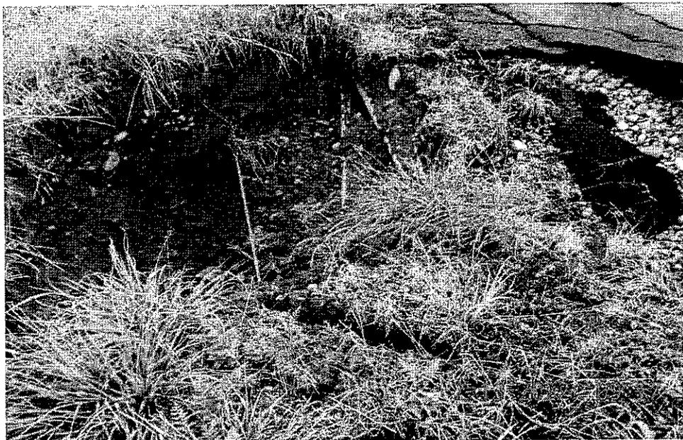
Abcisa 0+450 del umbral 24: Hundimiento de la franja de pista y espaldón de la pista
