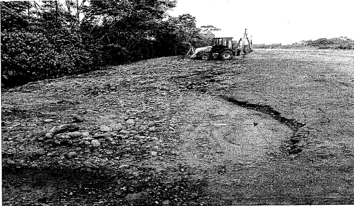
**Área rellena y compactada y lista para colocar mezcla asfáltica en el lugar del espaldón**
