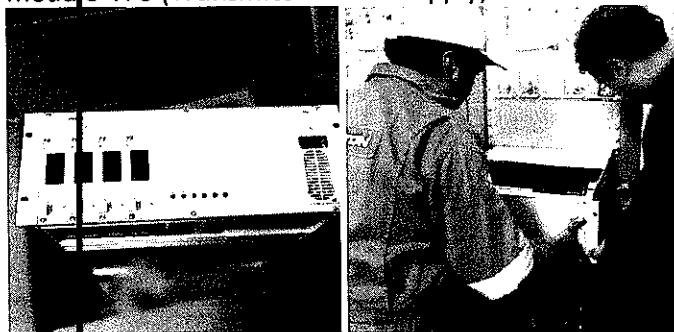
Cambio del módulo TPS (Transmitter Power Supply) del CANAL B.
