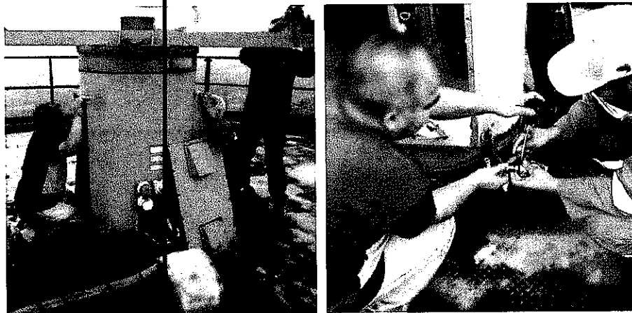
Ajuste del AZIMUT de los ENCODERs.
