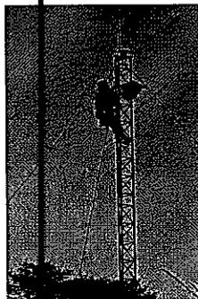
→ Desmontaje de los dos mástiles de antena, y desarmado de los mástiles en 5 tramos cada uno.
