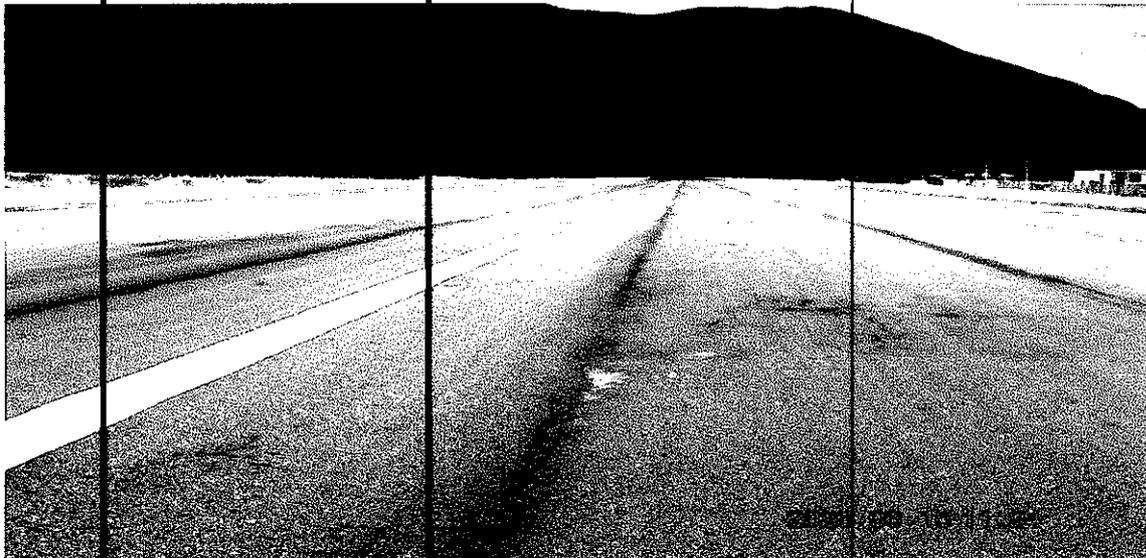
TOMA DE LA PISTA DESDE EL UMBRAL 27 AL UMBRAL 07 EN BUEN ESTADO PERO HAY QUE REALIZAR UN RIEGO DE UNA LECHADA DE ASFALTO PARA PROLONGAR LA VIDA UTIL DE LA PISTA
