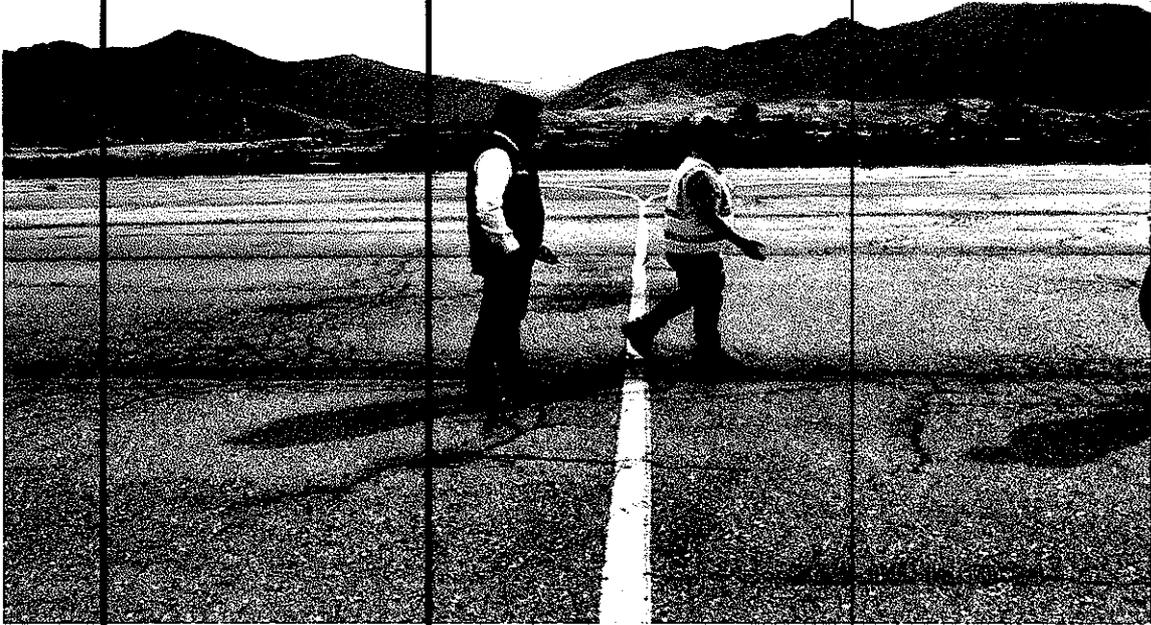
**FISURAS POLIEDRICAS O PIEL DE COCODRILLO Y LONGITUDINALES Y TRANSVERSALES**
