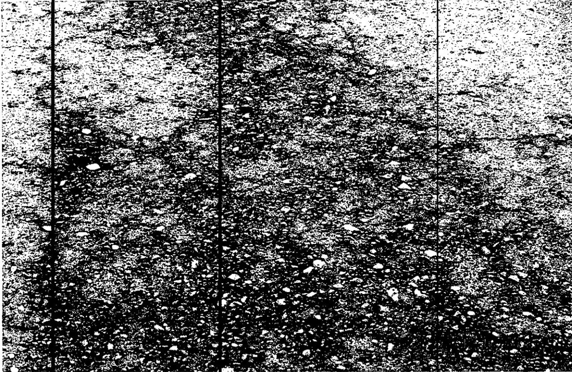
SECTOR DE LA PISTA CON PERDIDA DE FINOS NO HAY BACHE COMO TAMPOCO HAY DESPRENDIMIENTO DE MATERIAL SE DEBE DAR UNA LECHADA DE ASFALTO
