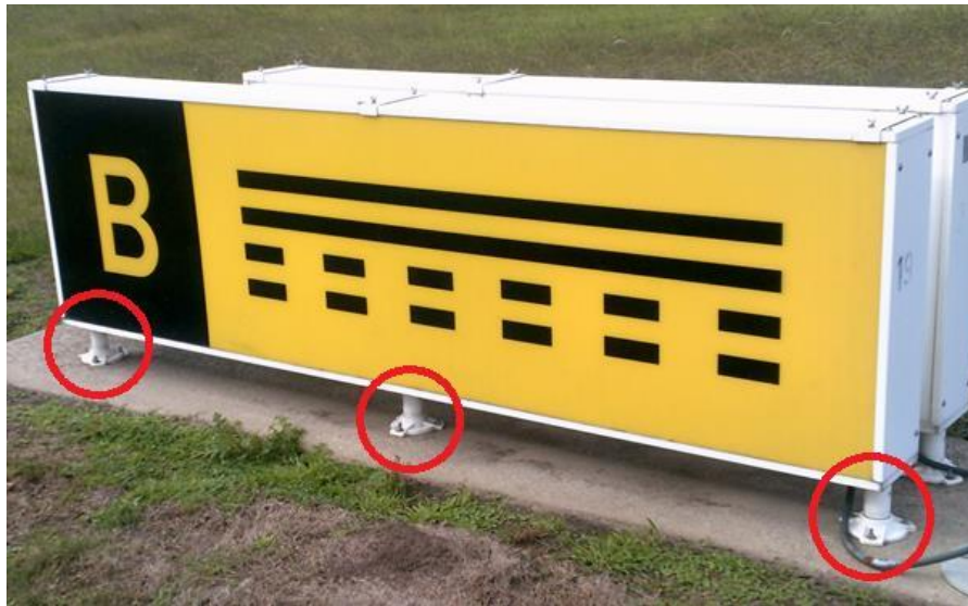
Figura 2-6-6. Ejemplos de cuplas Frangibles en las instalaciones de los Letreros
