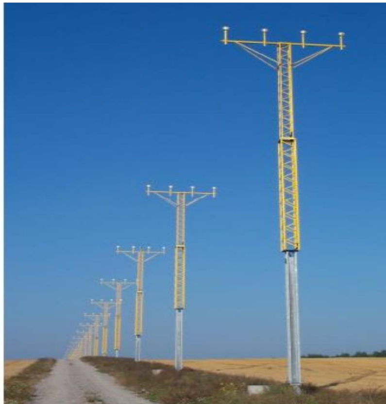
Figura 1 Torres de iluminación de aproximación de fibra de vidrio sobre e estructuras de soporte rígidas
