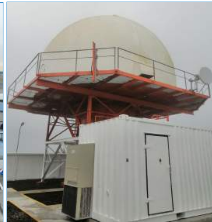
Radar San Cristóbal
