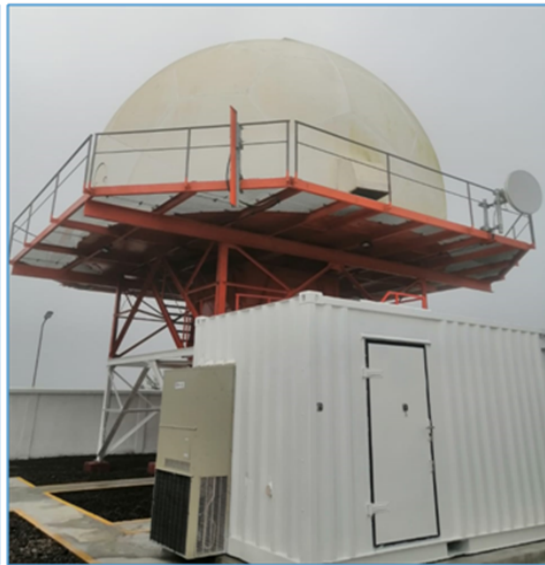
Radar San Cristóbal
