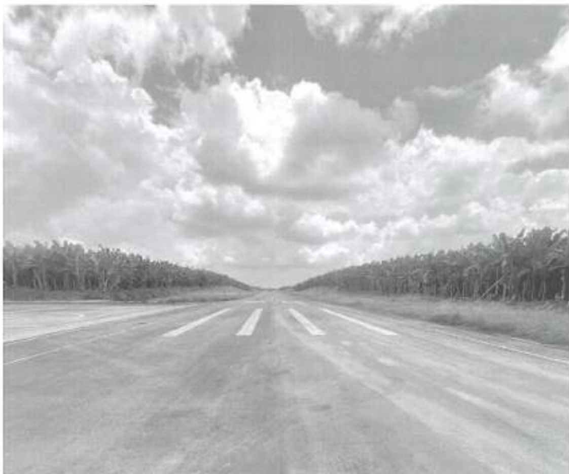
Fotografía #10.- Tomada desde cabecera #1 hacia cabecera #2.
