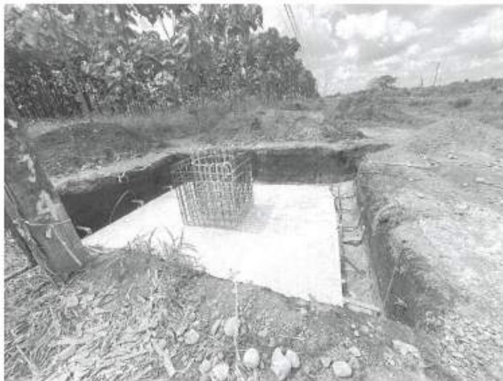
Fotografía #7.- Cimentación para colocación de poste.
