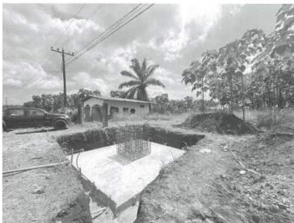
Fotografía #8.- Cimentación para colocación de poste tomado hacia interior.
