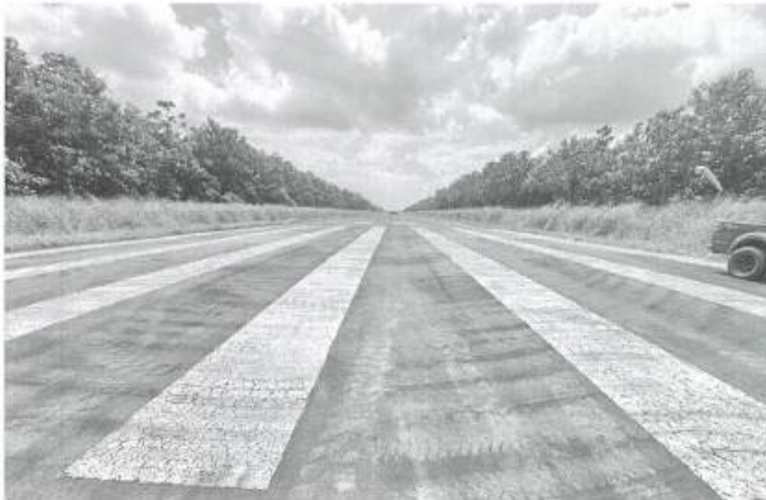
Fotografía #4.- Tomada desde cabecera #2 hacia cabecera #1
